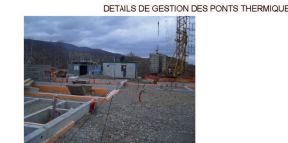
DETAILS DE GESTION DES PONTS THERMIQUES (ISOLATION DES LONGRINES BA)
