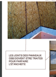
DETAILS DE GESTION DES PONTS THERMIQUES (ISOLATION DES LONGRINES BA)
