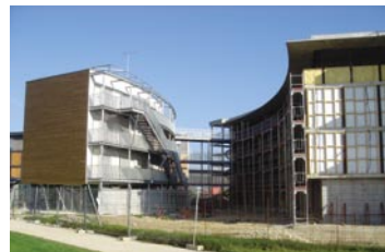
Vue rapprochée à partir du Nord
