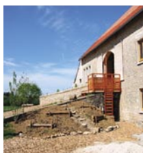
Entrée du second logement
