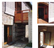
Entrées du bureau et des logements
