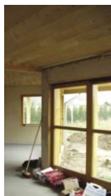
Baies au Sud
