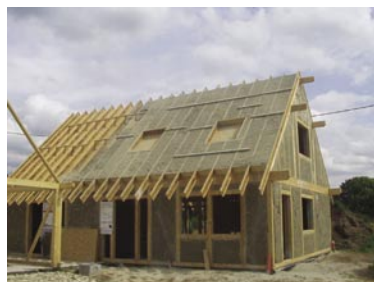
Façade rue chanvre projeté
