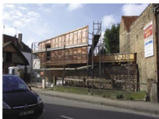
Construction de la façade coté rue
