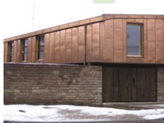
Réalisation finale - coté rue
