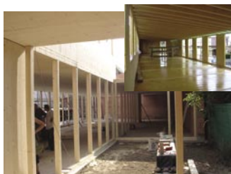
Vue du patio - ambiance intérieure avec vue sur la cour
