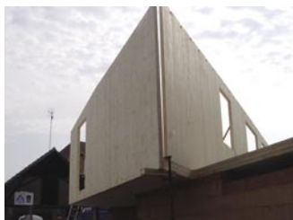
Construction - pignon coté rue
