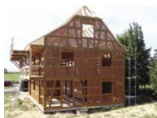
Ossature et aspect général en cour de construction
