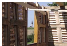
Préparation du remplissage de béton chanvre-chaux
