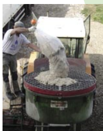
Malaxage du béton chanvre-chaux
